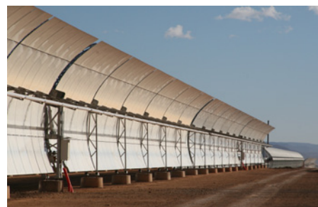
Miroir parabolique au centre le tube où circule le fluide caloporteur
