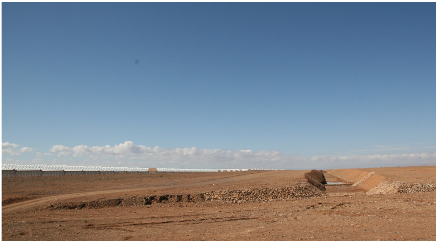
Au premier plan un des ouvrages destinés à drainer l'eau de pluie en cas de fort orage, les talus sont enrochés.
