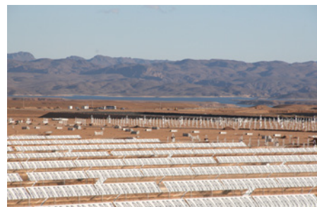
Au second plan on aperçoit les plots en attente des miroirs
