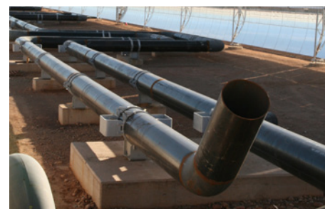
Tuyau où circule le fluide caloporteur
