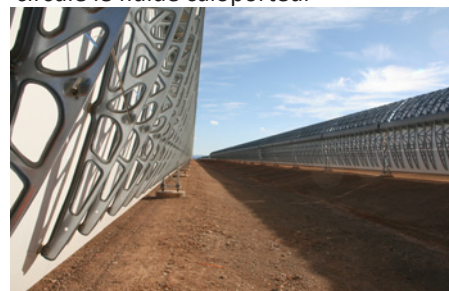
Miroir parabolique au centre le tube où circule le fluide caloporteur
